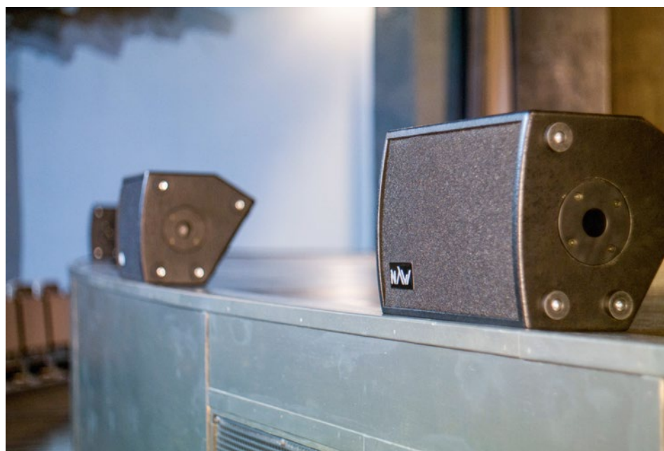
Cztery zestawy NAW MS8 pełnią funkcję frontfilli dogłaśniających pierwsze rzędy widowni.
